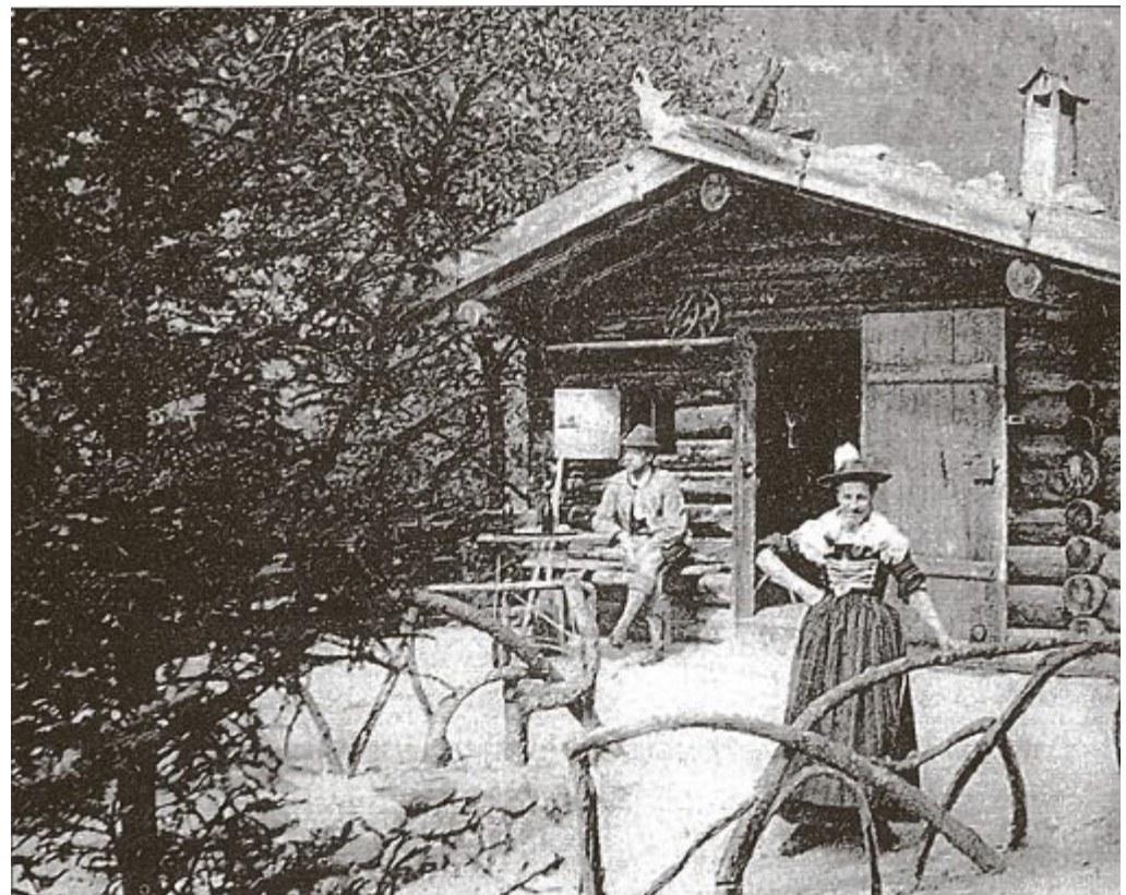
Sennhütte im Wittelsbacher Park um 1900. Bereits im Jahre 1887 legte der damalige Verschönerungsverein den Park an. Seit 1908 sind dort schon Feste des Volkstrachtenvereins überliefert
